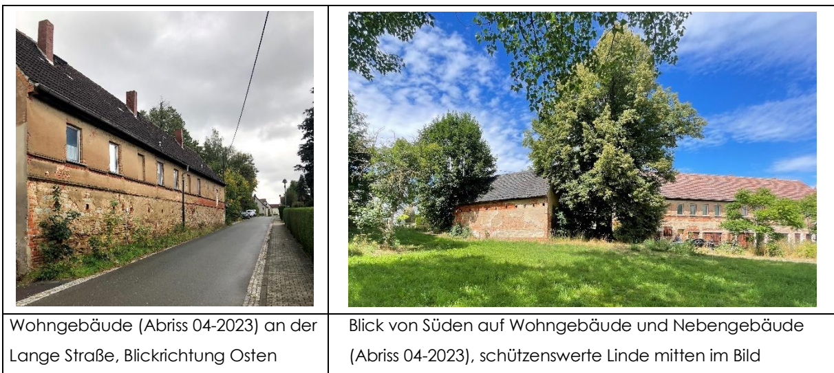
Abb. 4 | Bestandsbilder Plangebiet, Vorhabenträger, 04.05.2023
