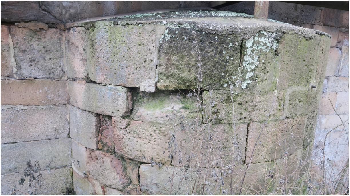
Schadhaftes Sandsteinmauerwerk, Pfeiler unterstrom
