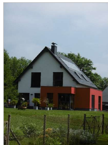
Einfamilienhaus am Stadtrand, Schmölln
