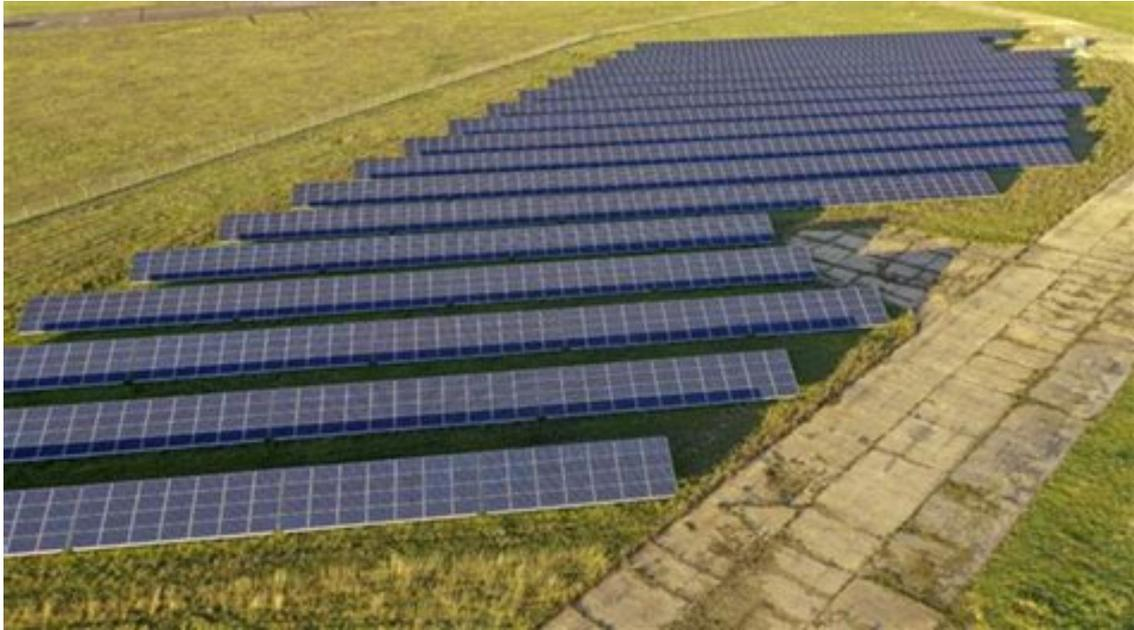
Abbildung 8: Beispiel für aufgeständerte Solarmodule
